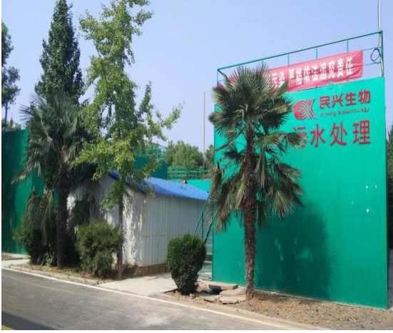
2017年3月日处理600吨污水处理投入运行
