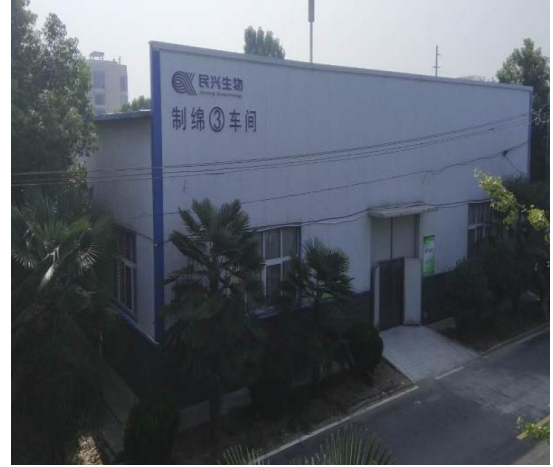
2017年5月制绵三车间投入运行
