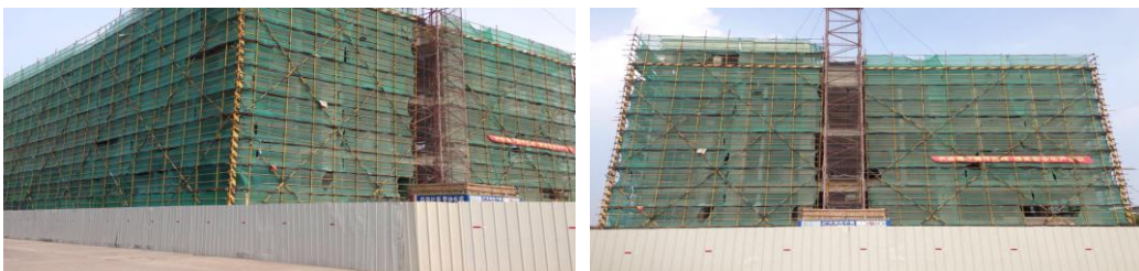
为扩大生产、优化物流仓储，目前在新建厂房
